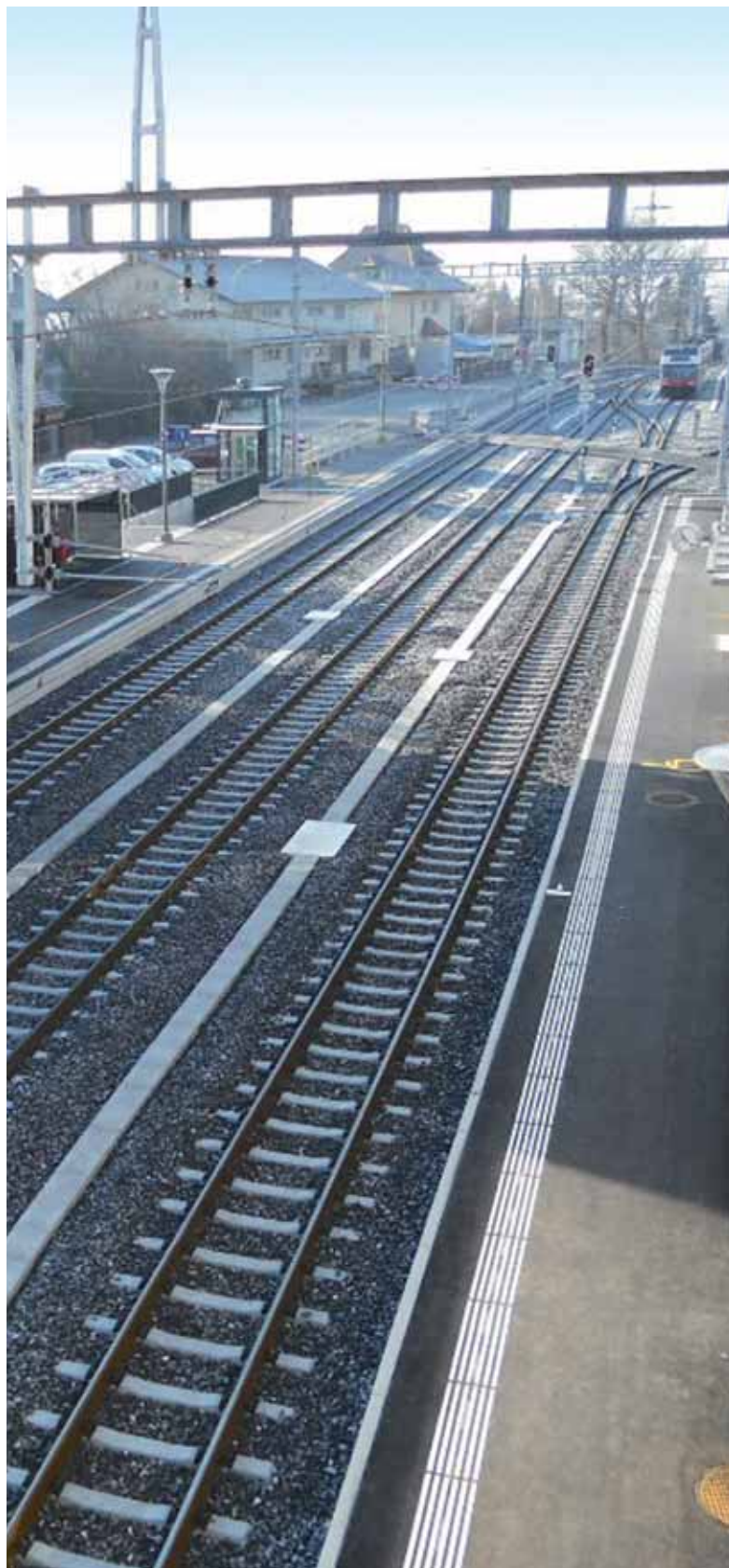
Blick auf die neue Gleisanlage in Täuffelen.
