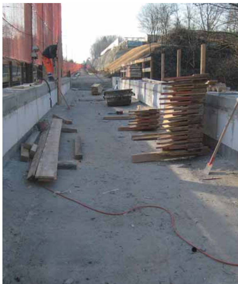
Momentaufnahme der Arbeiten an der neuen Brücke über die Siggere.
